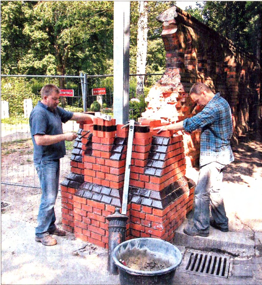
Bei der Arbeit: Die Maurer Detlef Schober (links) und Andreas Schneemann.
